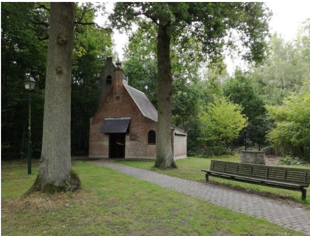
Kapelletje aan de Schoorstraat.
